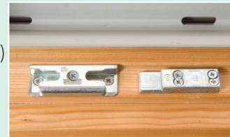
Pilzzapfenverriegelung und Alarmkontakt
